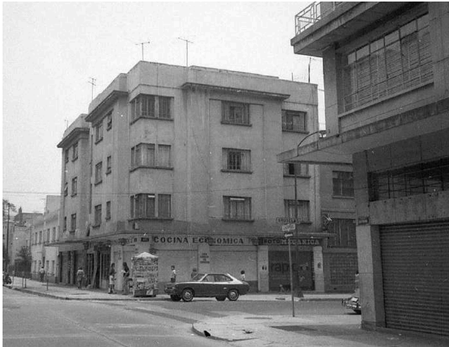
Figura 2. Cruce de las calles Bruselas y Liverpool, en la colonia Juárez. A la derecha, el edificio de departamentos que se derrumbó el 19 de septiembre de 1985. Rockdrigo González vivía ahí.
