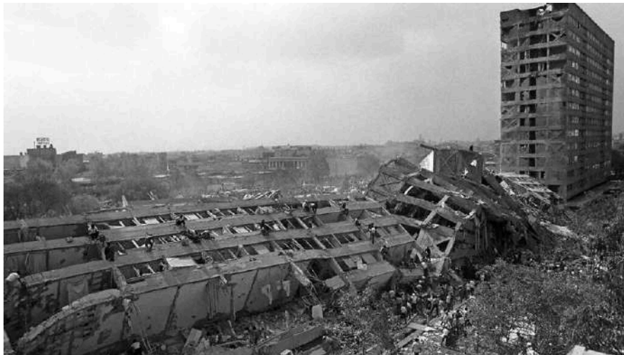
Figura 1. Edificio Nuevo León, Tlatelolco, 19 de septiembre de 1985.
