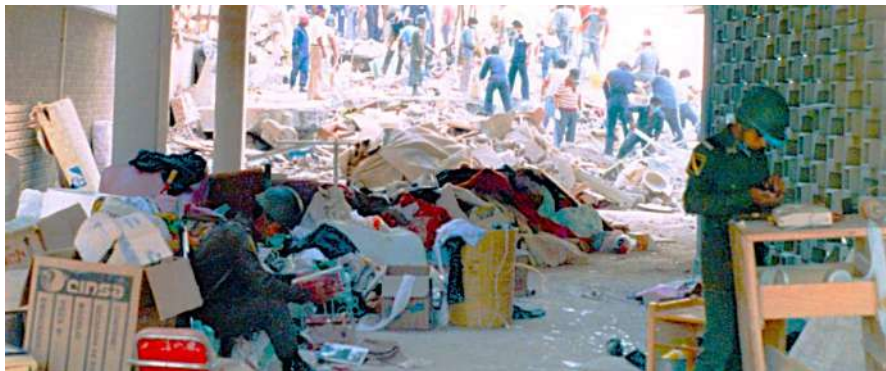
Imagen 1. Fotografía tomada el 25 de septiembre de 1985 en edificio colapsado del centro de la Ciudad de México. Autor: Jesús Manuel Macías M.
