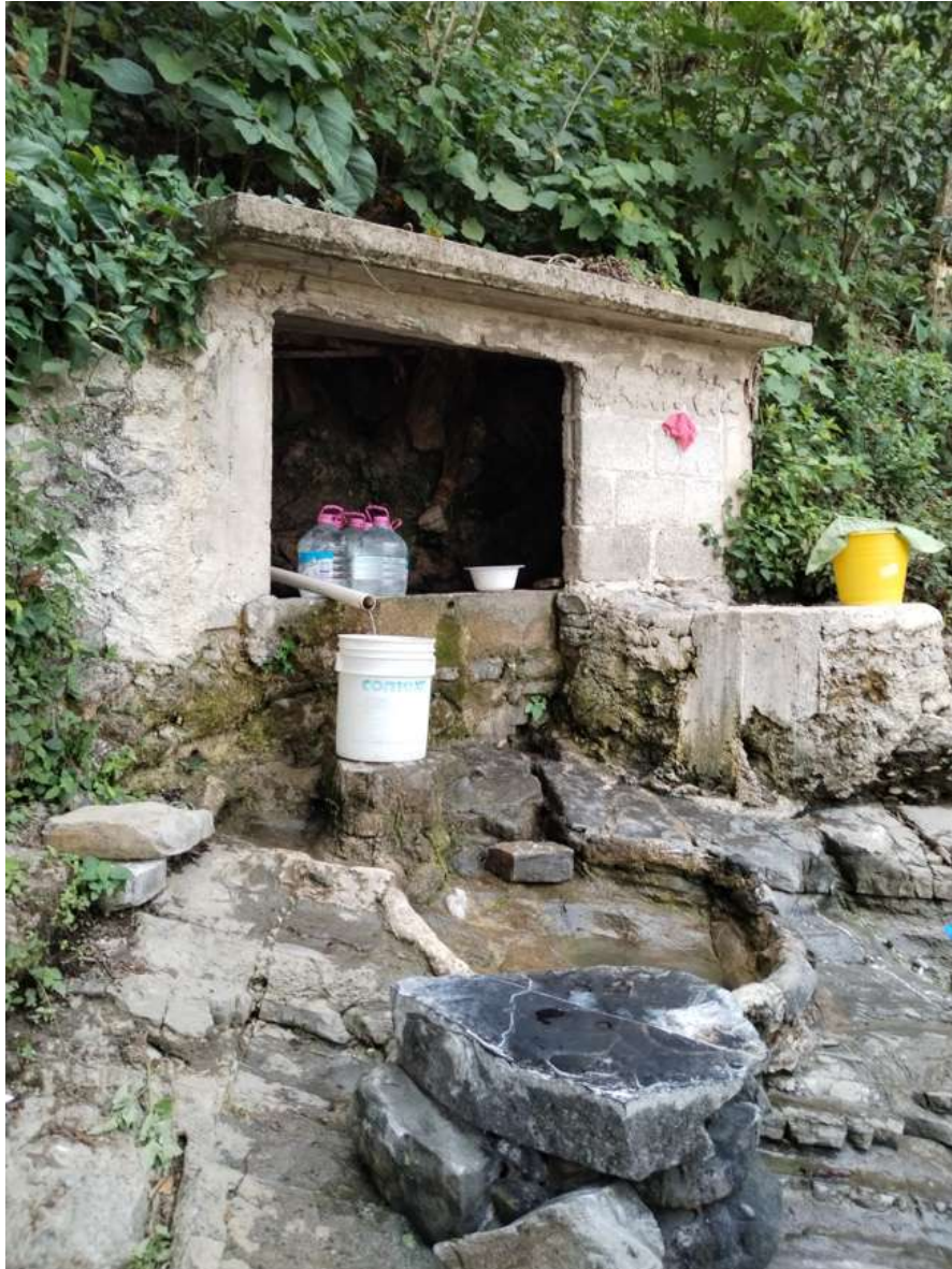
Imagen 4. Enseres formados y siendo llenados en el pozo Dzudehe. Acervo personal del autor
